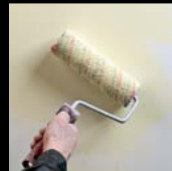
2. Нанесение краски Interior 3
