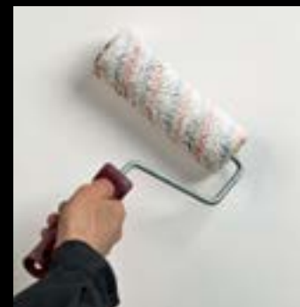
1. Нанесение грунта «LATEKSI_PRIMER»
