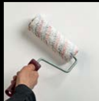
1. Нанесение грунта «Универсал Праймер»
