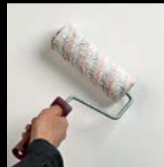
1. Нанесение грунта «UNI_Primer»
