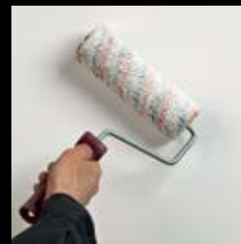
1. Нанесение грунта «UNI_Primer»
