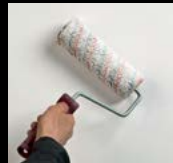
1. Нанесение грунта «LATEKSI_PRIMER»
