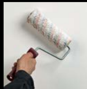
1. Нанесение грунта «Lateksi_Primer»
