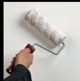
1. Нанесение грунта «UNI_Primer»
